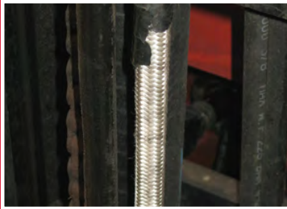
Schäden an den Schläuchen
